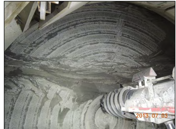
Machine à attaque ponctuelle sous jupe
