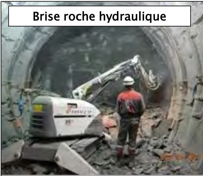
Machine à attaque ponctuelle
